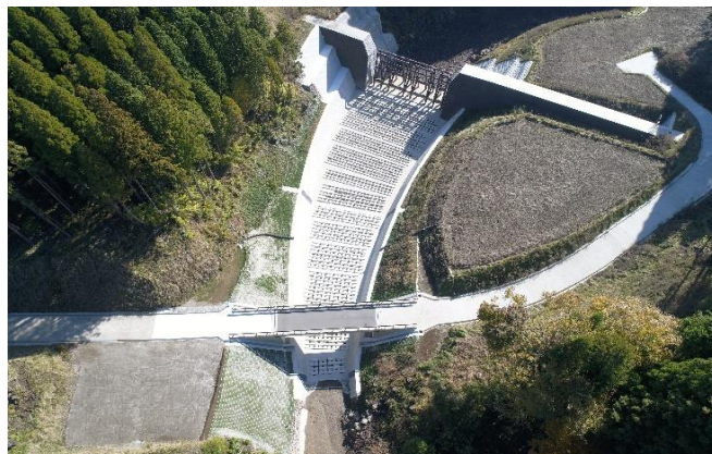
現場上空写真
