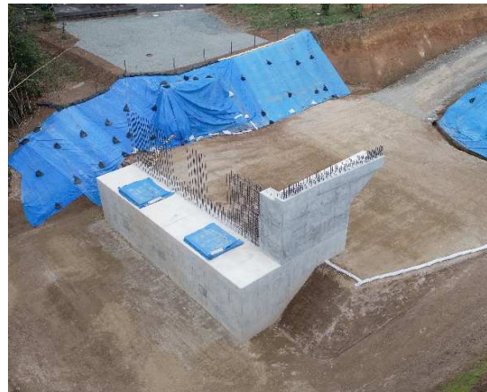
現場上空写真
